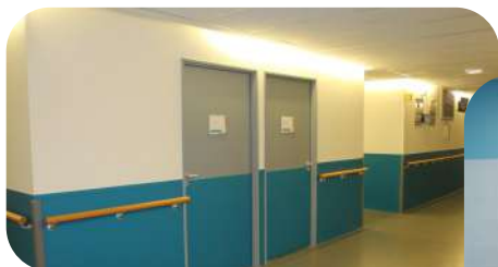
Nouvelles peintures, rajout de rampes dans les couloirs
