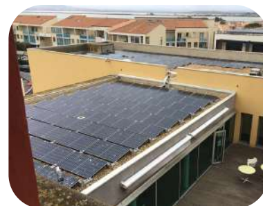
Pose de panneaux solaires permettant de diminuer de 30 % les consommations d'énergie
